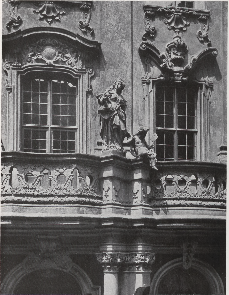
12. BALKON ÜBER DEM HAUPTPORTAL
